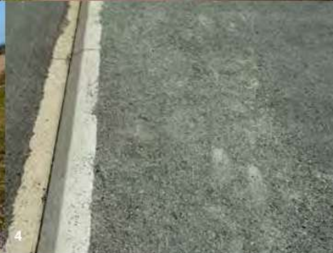
2- CHEMINEMENT EN BICOUCHE AVEC GRAVILLONS ROUGES. 4- TROTTOIR EN BICOUCHE GRIS.
